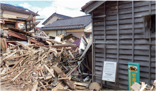
輪島市の景観重要建造物に指定されていた住宅が 完全に倒壊していた
