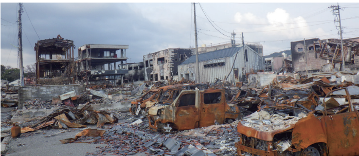
大火にあった輪島朝市 3ヶ月経ってもこの状態 300世帯が焼失したという
