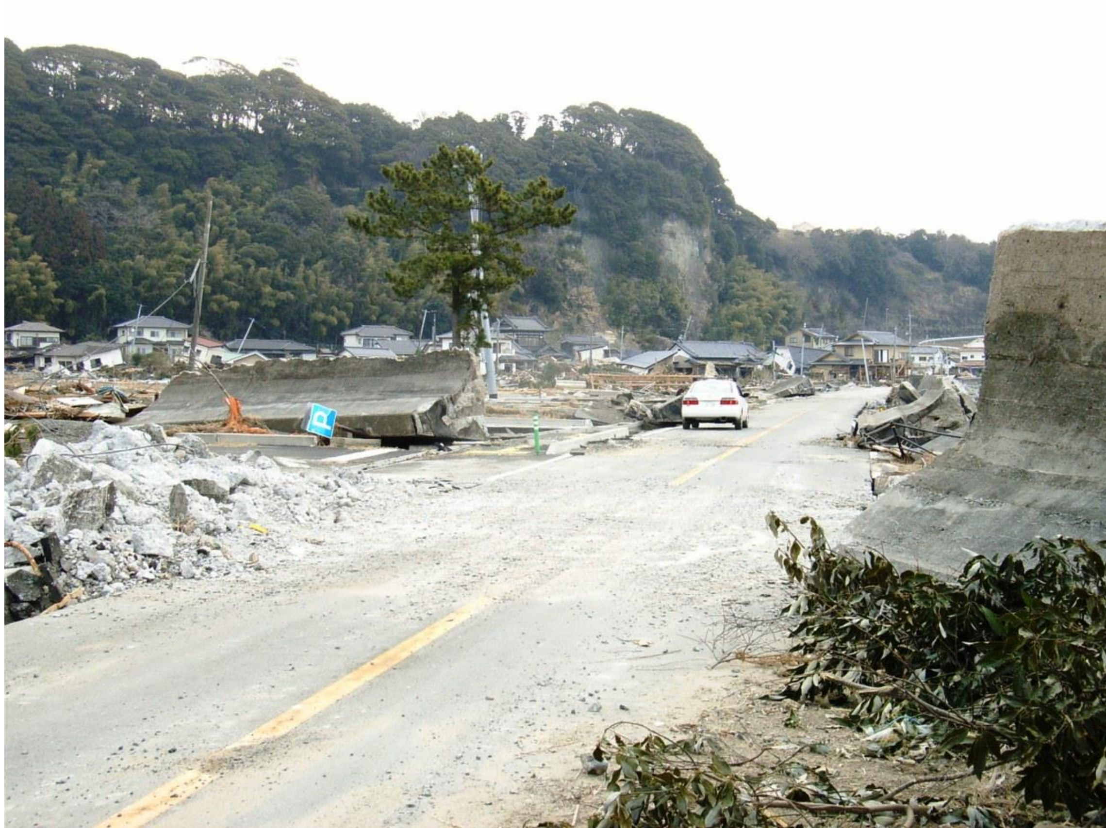
いわき市岩間地区の様子 コンクリート製の堤防が20m.も飛ばされているのが分かる
