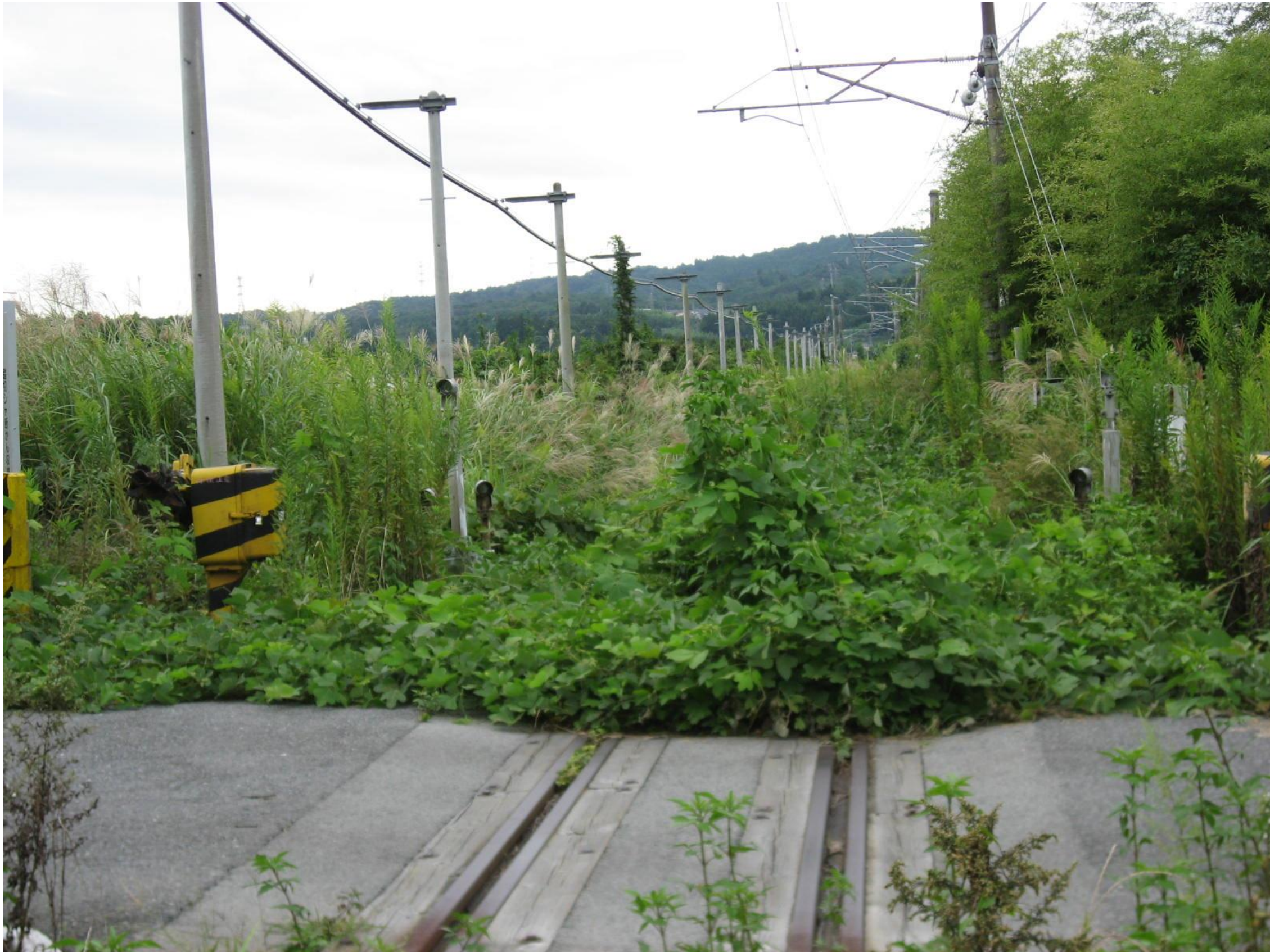
2012年夏 檜葉町の JR 常磐線 草に覆われ、上に架線が走っていなければ、線路とわからないほどになっている。
