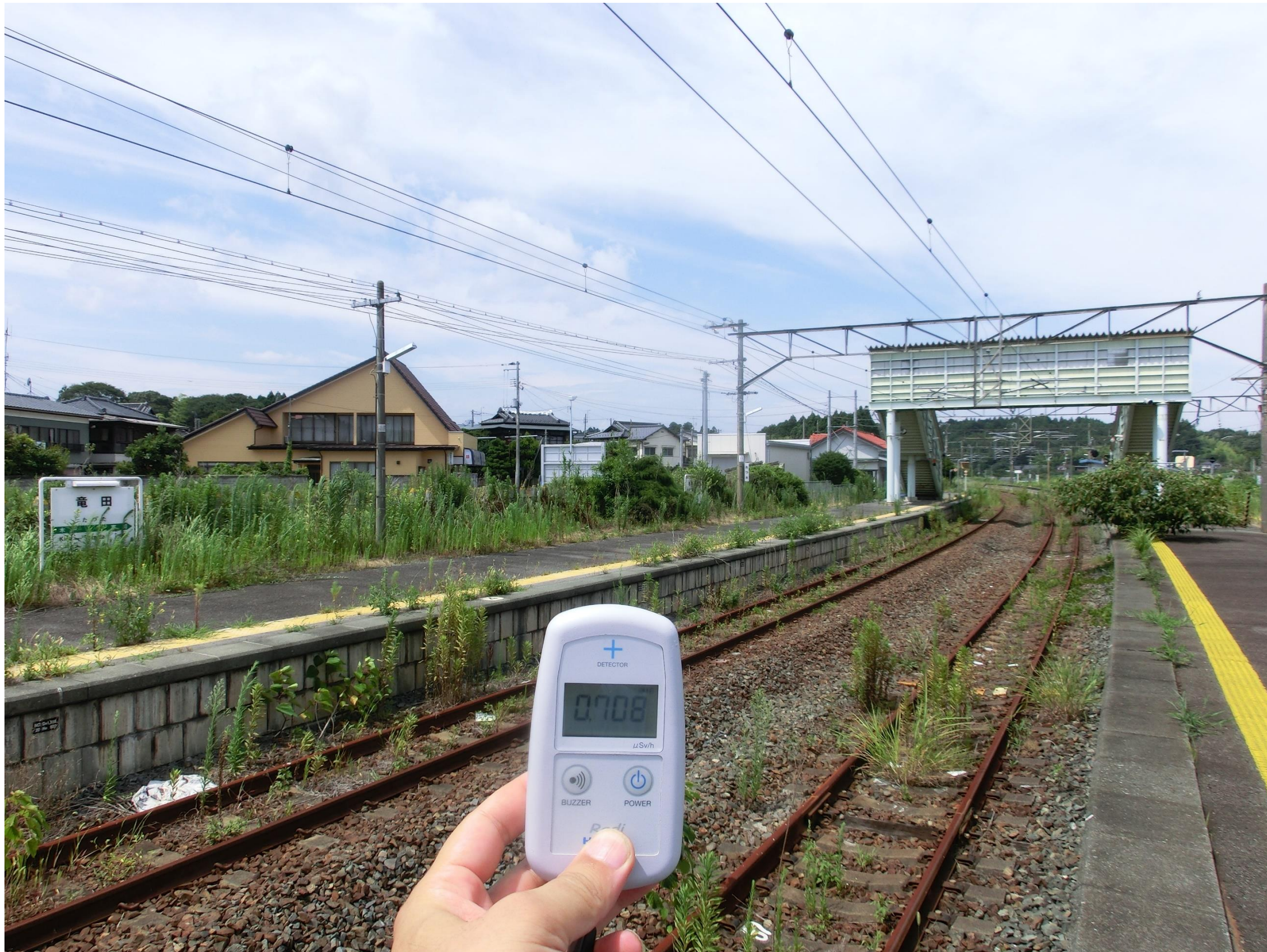
2012年8月 檜葉町にあるJR常磐線の竜田駅。レールは錆び、線路にもホームにも草が生え、廃線同然。放射線量は 0.7\mu\text{Sv/h}
