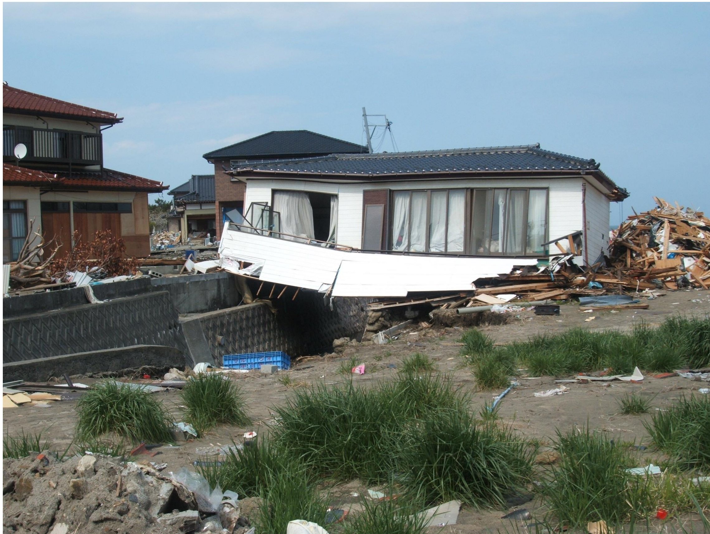
津波被害のひどかったいわき市平豊間地区。引き波で家が流され、住宅の二階部分が川の中に引っ掛かっている。
