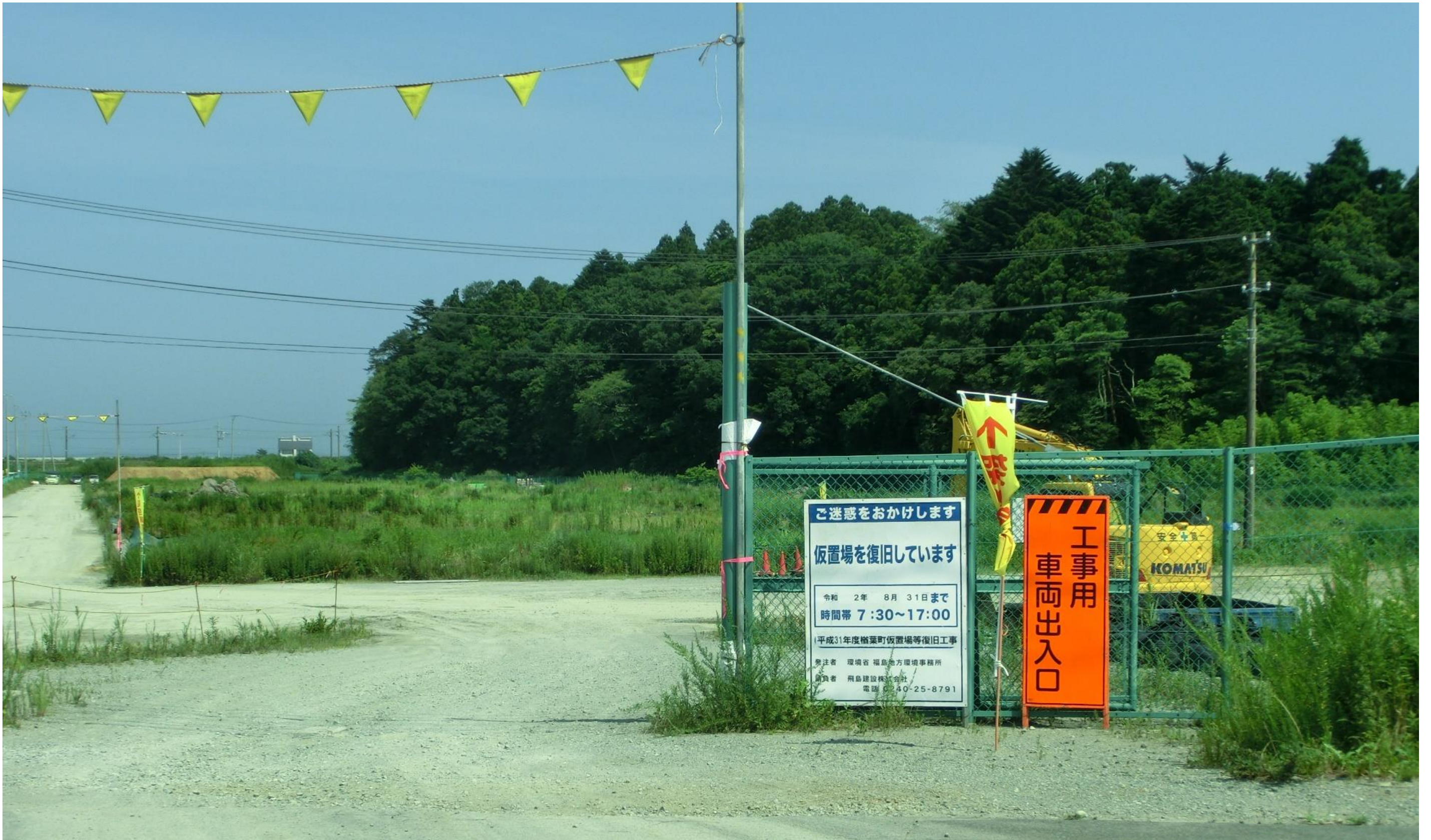
檜葉町の仮置き場。フレコンバックに詰められた除染廃棄物を中間貯蔵施設に移送する作業が終わり、元の田んぼに原状復帰中。2019年8月撮影
